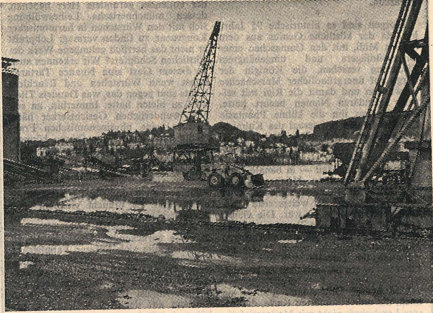
Geplant war hier ein Seeuferweg — gebaut wurde ein Kieswerk. Foto Grat
